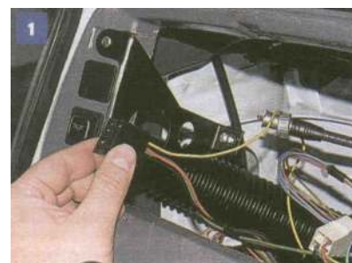
Odlączamy wtyczki od wyłącznika plafonów kabiny i tylnego światła przeciwmgłowego.
